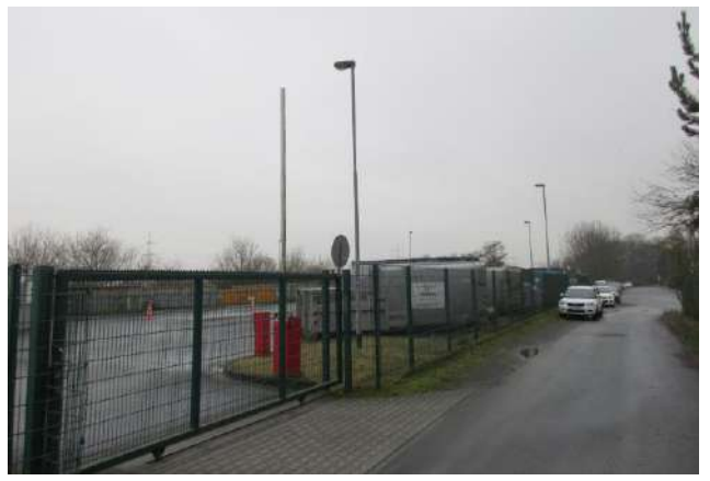
Max-Planck-Strasse 44 – Blickrichtung Westen, auf Recyclinghof (Südöstlicher Eckpunkt des Geltungsbereiches)
